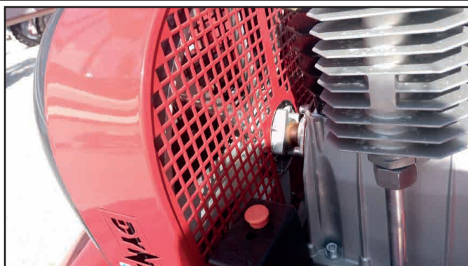
Kuva 6.6: Tarkasta hydraulisen kompressorin puhtaus, vuodot ja vauriot
