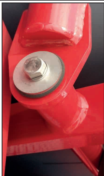
Kuva 2.3: Tarkasta tasauslevyt vaurioiden varalta
